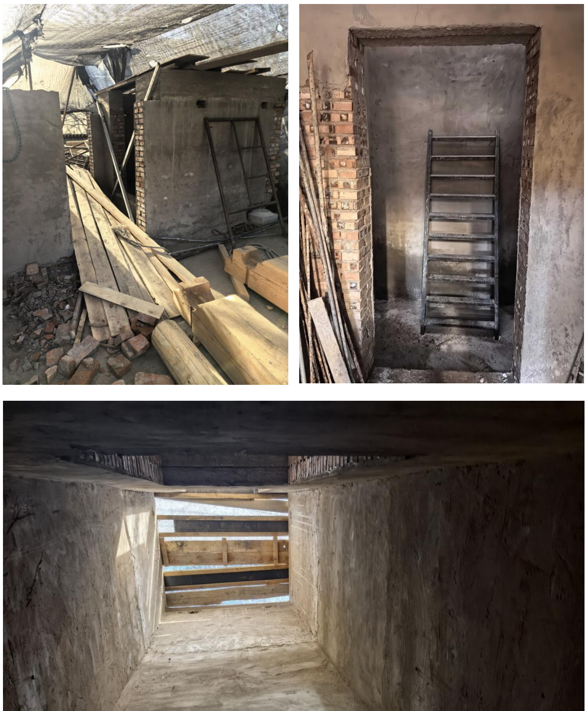
图 3 事发房屋的竖井
